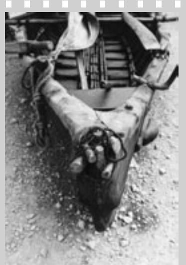
на северо-западе Невады, состояли из трех толстых пучков камыша, из которых два наружных имели веретенообразную форму, а третий, посередине, был короче и одинаковой толщины. Связывался камыш ивовыми прутьями. Через каждый пучок была горизонтально пропущена палка для жесткости. Лодка двигалась при помощи шеста. Вес лодки был небольшой: ее могли нести один или двое индейцев.
